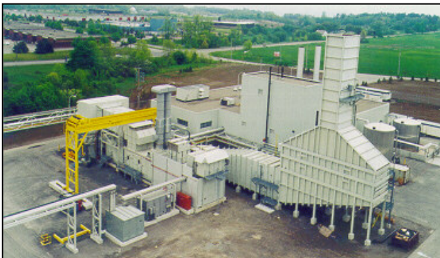
Whitby Cogeneration Plant – RR Trent + IST OTSG
